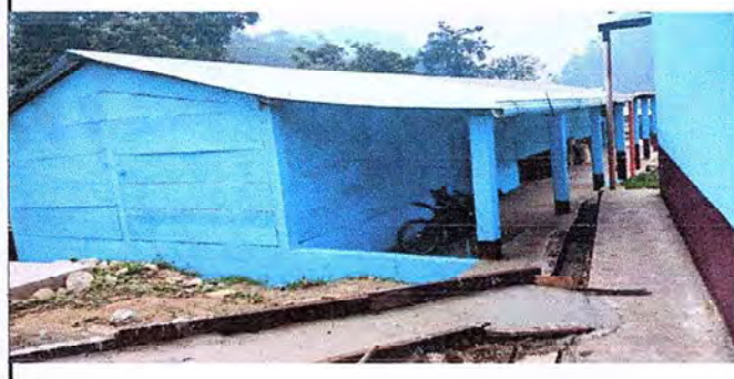
Foto 4: Se observa la bodega del establecimiento en buen estado modulo 3
