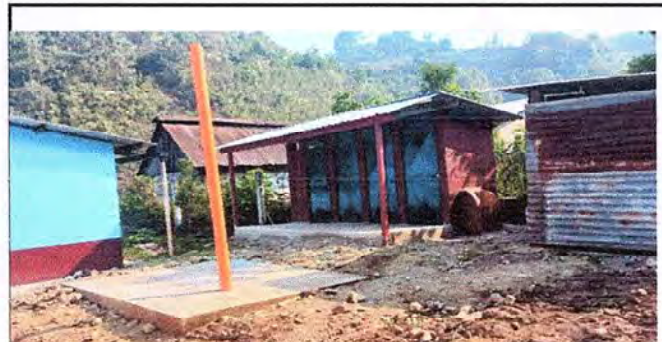
Foto 6: Se observa el mantemiento de letrina.
