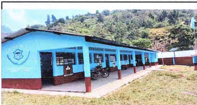
Foto 1: Se observa que la pintura del establecimiento ya esta pintada de todo las paredes al interior y al exterior en el modulo 2
